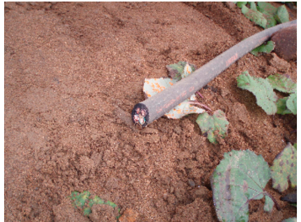
Pohled na kabel poškozený pachatelem
