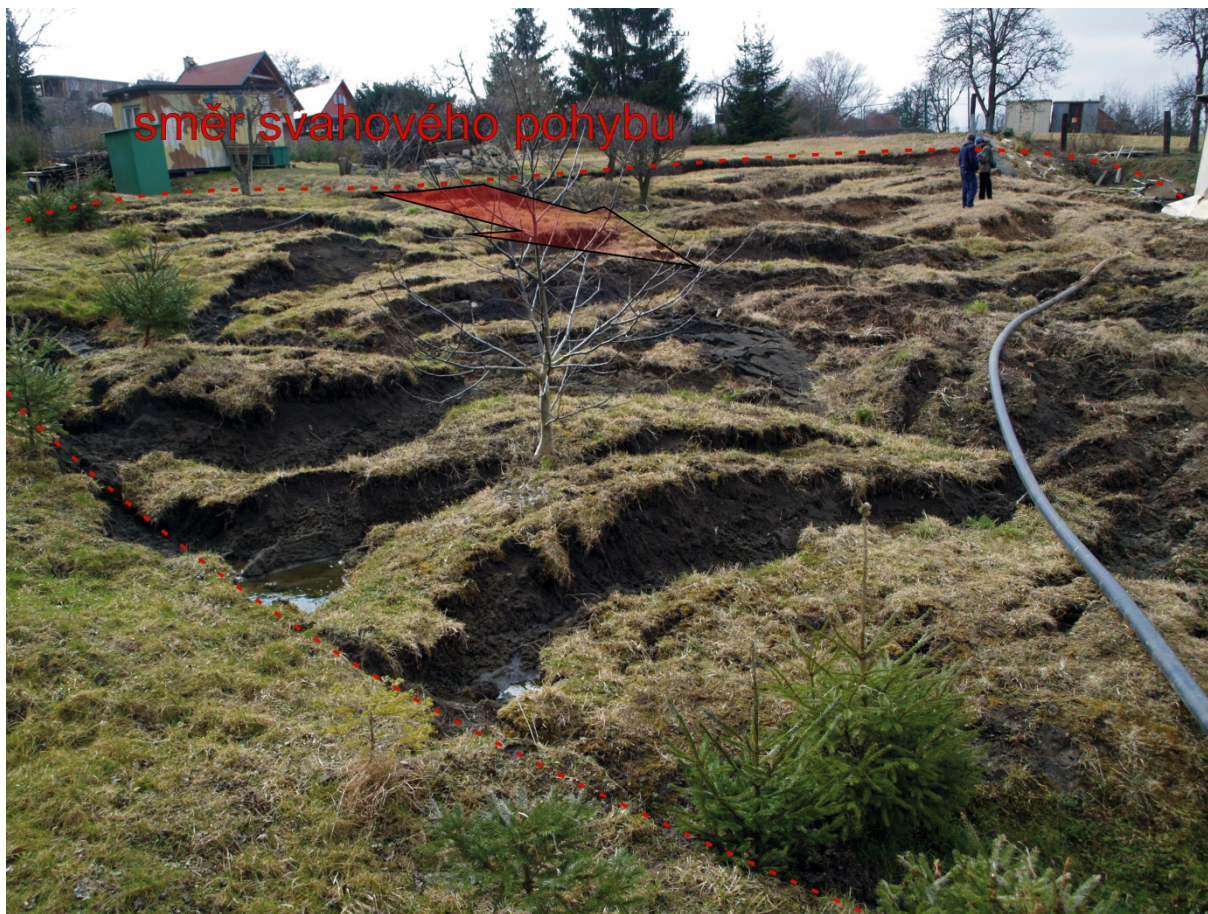
Foto 1. Odlučná oblast sesuvu A zdeformovaná systémem odlučných trhlin.
