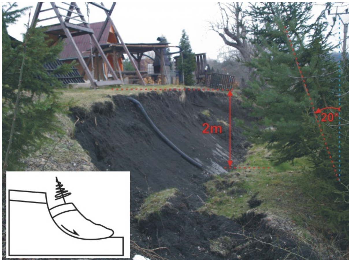
Foto 8. Odlučná stěna svahové deformace C s obnaženou odvodňovací rourou, vychýlené stromy na tělese sesuvu.
