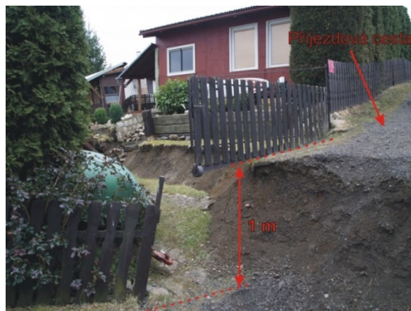
Foto 5. Odlučná stěna sesuvu B protínající příjezdovou silnici do chatové oblasti.
