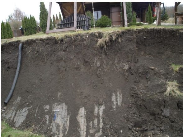
Foto 9. Odlučná stěna s obnaženou odvodňovací rourou a zjevnými striacemi na smykové ploše svahové deformace C.
