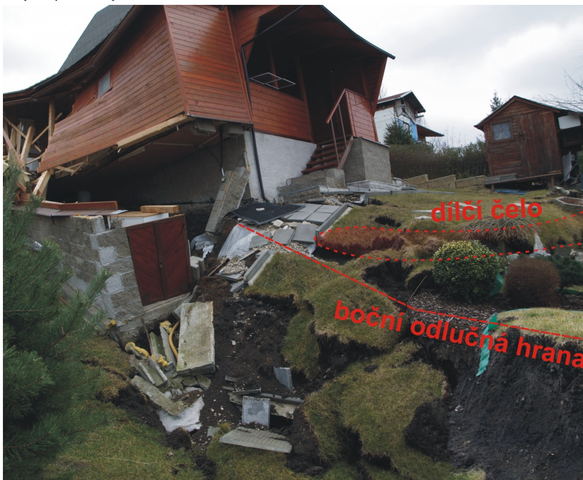
Foto 6. Pravá boční odlučná hrana sesuvu B poškozující chatový objekt a přibrzděné sesuvné čelo.
