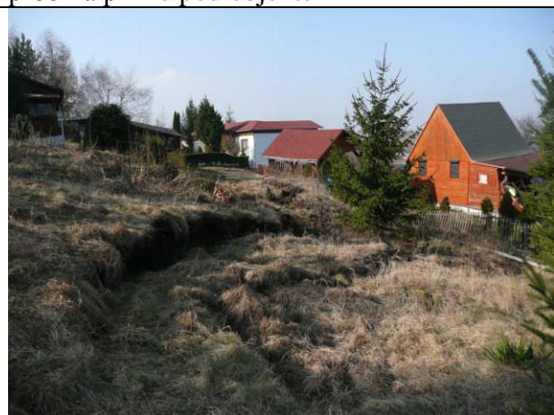
horní odlučná hrana sesuvu s trhlinami
