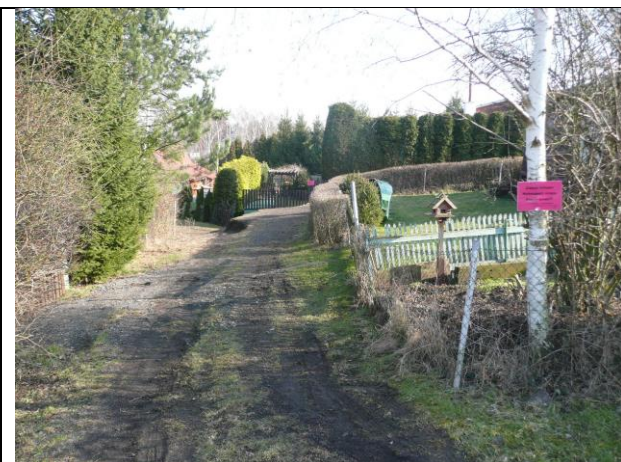
účelová komunikace porušená odlučnými hranami sesuvu
