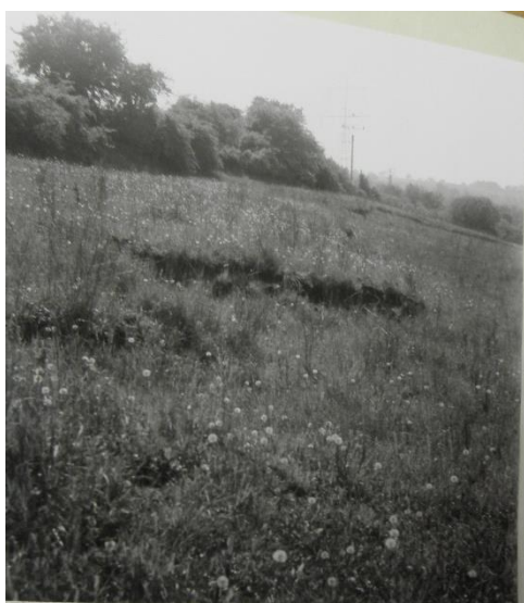
(6470A, Rybář, 27.května 1969, SZ od pevného bodu S4, kóta hladiny 266,51 m n.m., 1.prázdňení nádrže, hladina klesá průměrně o 18 cm/den.) Odlučná oblast sesuvu, který vznikl při patě svahu pod obcí Poláky při prázdňení nádrže.
