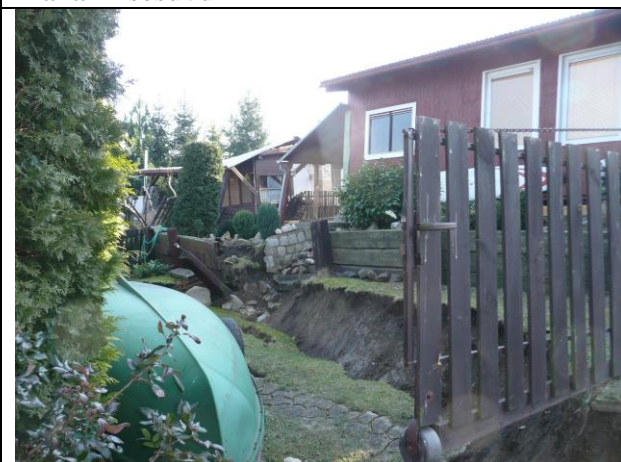
objekty porušené sesuvem, výška hrany sesuvu cca 1 m
