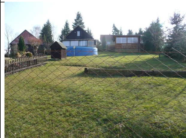
neporušená část svahu, napuštěný bazén zatěžuje svah a jeho podloží – potenciální smykovou plochu
